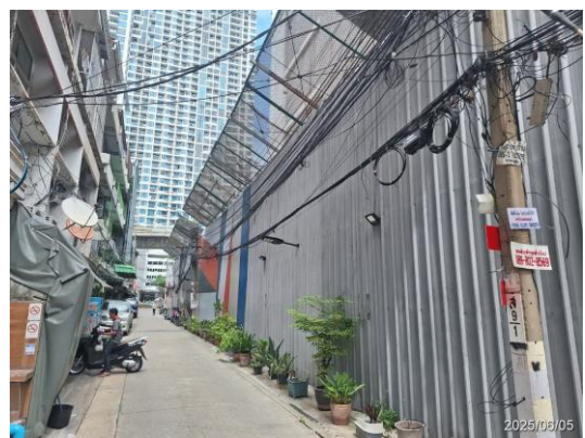
รูปที่ 3-6 Catch Fan ผังที่ติดกับชุมชน
