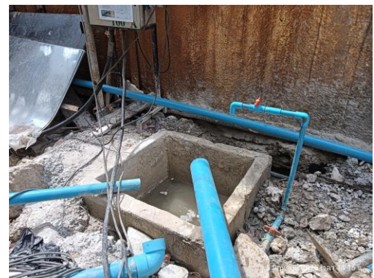
รูปที่ 3-47 บ่อพักน้ำสุดท้ายก่อนระบายลงท่อระบายน้ำสาธารณะ
