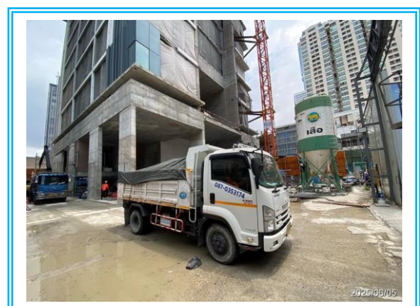
รูปที่ 3-31 รถบรรทุกขนส่งวัสดุก่อสร้างมีผ้าใบปิดคลุม
