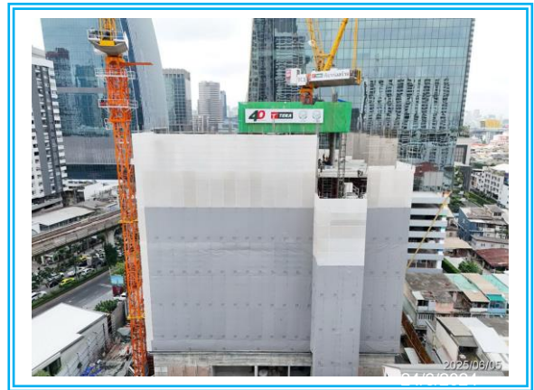
รูปที่ 3-23 ผ้าใบก่อสร้างปิดคลุมตามความสูงอาคาร ขณะก่อสร้าง
