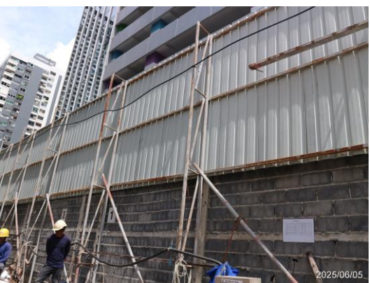
รูปที่ 3-5 รั้ว Metal Sheet ความสูง 6 เมตร โดยรอบพื้นที่ก่อสร้าง
